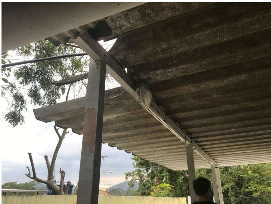
Figuras 11 e 12 - Telhas quebradas e comprometidas, gerando infiltração
