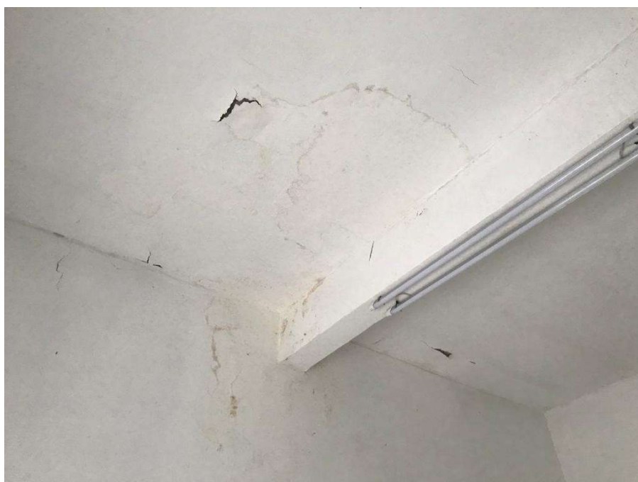
Figuras 3, 4 e 5 – Pontos de infiltração da laje na sala de inundação
